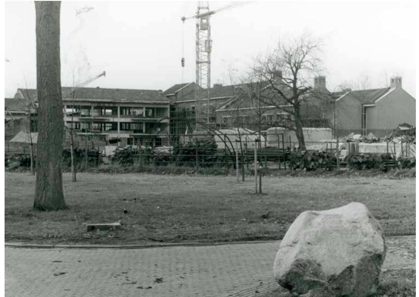
Figuur 10: Het hoofdgebouw van de Wachttorengenootschap in aanbouw in 1982 (bron hierkomjijweg.nl).
