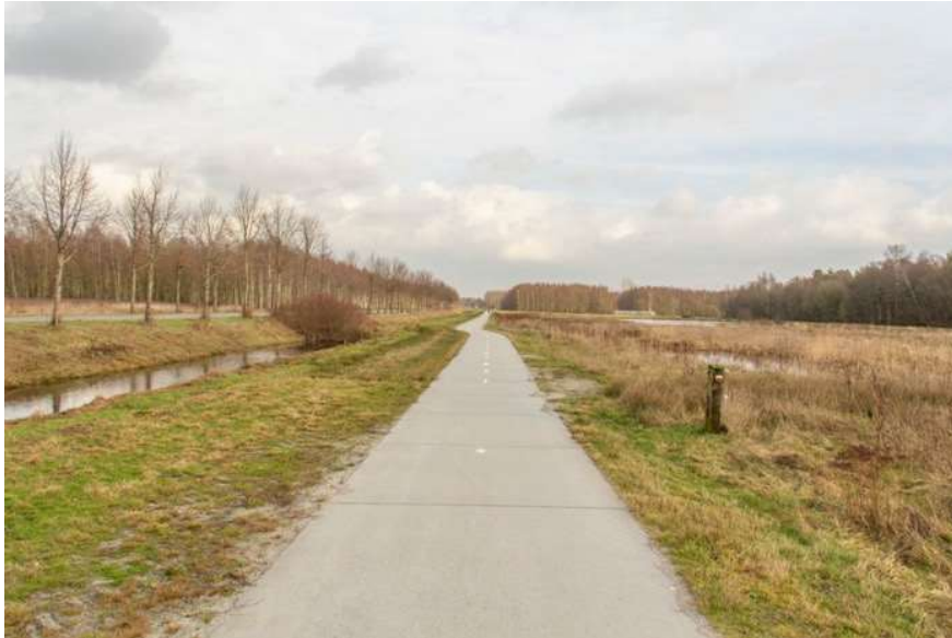
Foto: Verlengde Splitting in Barger Oosterveld; Geen verlichting want geen sociale controle. Wel een lichter wegdek waardoor het verloop van de weg goed zichtbaar is.
